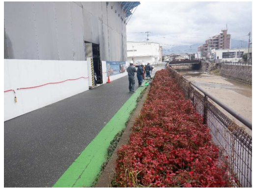
工事現場周り清掃
